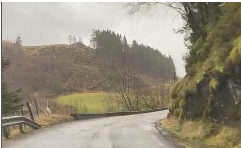
Figur 15: Redusert sikt i innerkurve på fv. 5308
