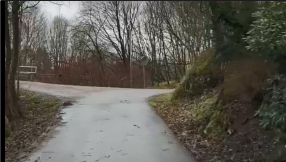
Figur 19: Bilde som viser krapp kurve uten sikt på Buøyveien. Vegen går vidare til høgre i bildet. Mange skuleelevar kjem frå venstre i bildet og skal inn vegen til høgre (mot skulen).
