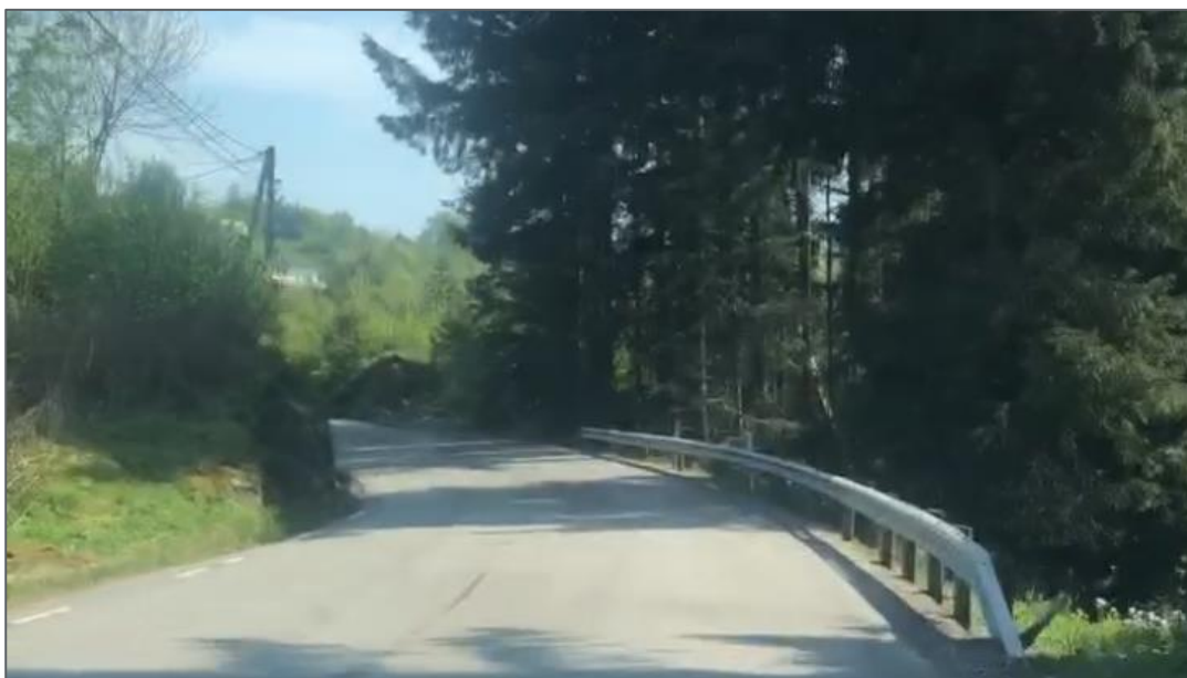
Bilete 1: Bilete på strekninga med dårleg sikt, skjeringar og fyllingar der det er liten eller ingen plass på utsida av kvitstripa på fv.409 Radøyvegen
