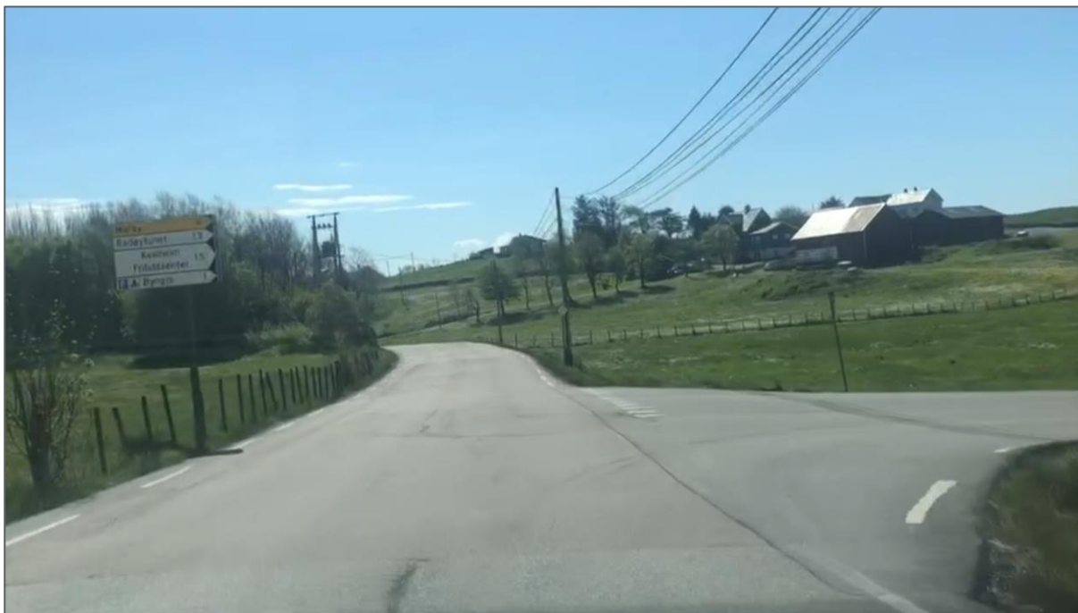
Bilete 16: Bilete frå strekninga søraust for Hordabø skule ved Kryss fv. 209 x fv. 414 på fv. 409 Radøyvegen, fartsgrense 50 km/t. Vurdert som særleg farleg/vanskeleg strekning for 1. og 2. klasse.
