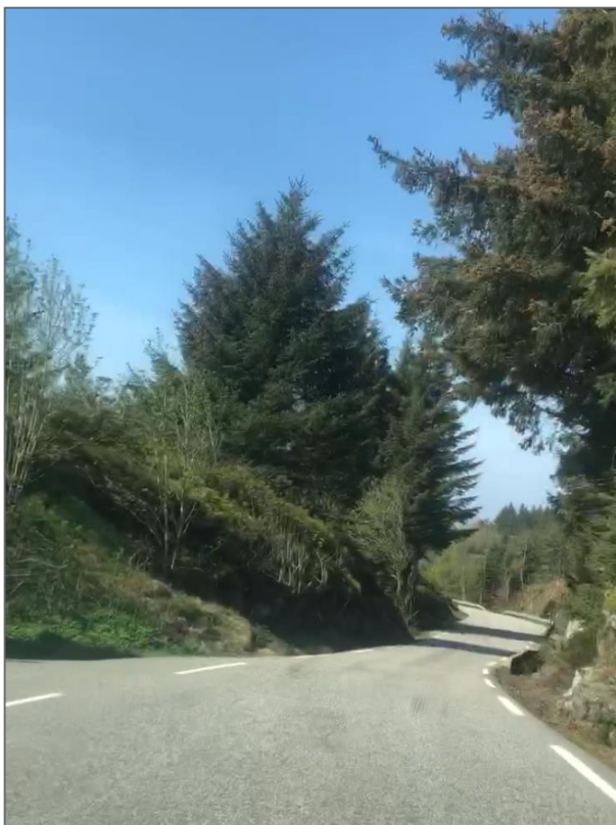
Bilete 7: Bilete på strekninga med skjeringar og fyllingar der det er liten eller ingen plass på utsida av kvitstripa på fv. 410 Toskavegen, fartsgrense 50 km/t
