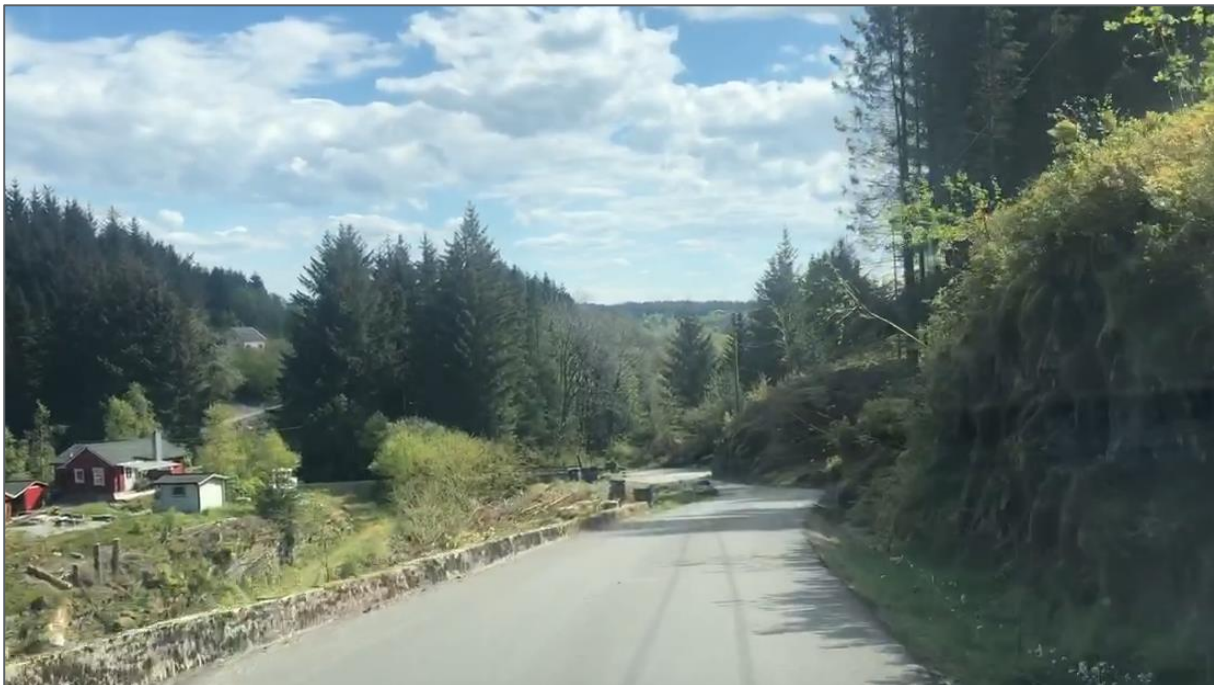
Bilete 21: Bilete frå strekninga ved Støvløringen på kv. 6052 Listveitvegen, fartsgrense 50 km/t. Her er det skjeringar og bratte fyllingar der det er liten eller ingen plass på utsida av vegen.
